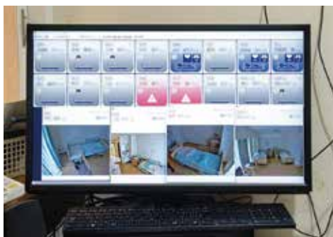
眠りSCANで得られたデータや、見守りセンサーで撮影された映像がパソコンの画面に表示され、スタッフが利用者さんの状況をリアルタイムで把握できるようになっています。
